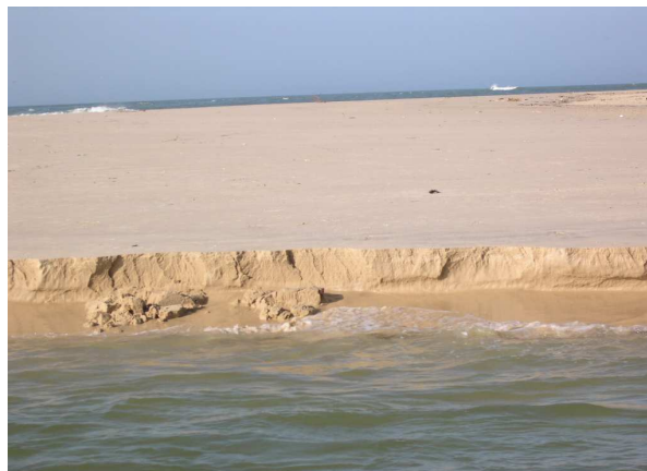
Figure 5 : Erosion par sapement de la berge droite
