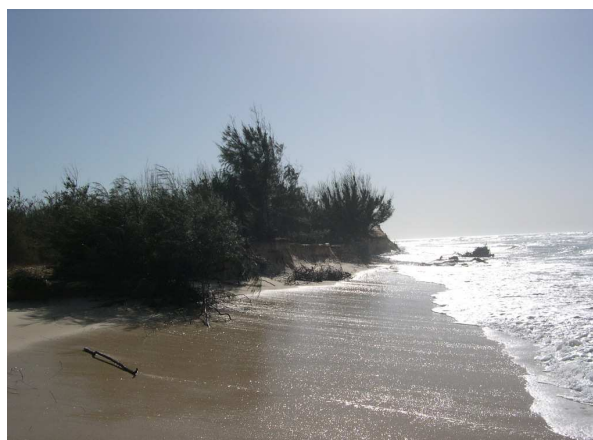
Figure 6. Erosion de la berge gauche exposée aux vagues
